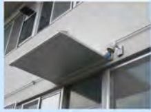
アルミ庇・人感センサ付LED照明器具取付け
