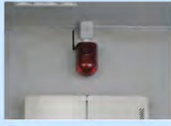
緊急通報装置の取付け
